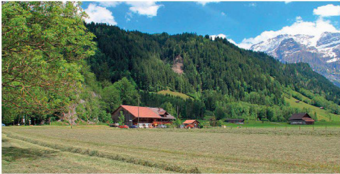
01 Bestehendes Wohnheim im ehemaligen Bauernhaus (Foto: Jurybericht)
