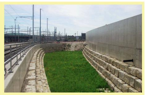
08 Die Versickerungsbecken sind so dimensioniert, dass sie abhängig von der Einzugsgebietsfläche auch das Wasser von einem Starkniederschlag auffangen können, inkl. Sicherheitsfaktor. (Bild: SBB)
