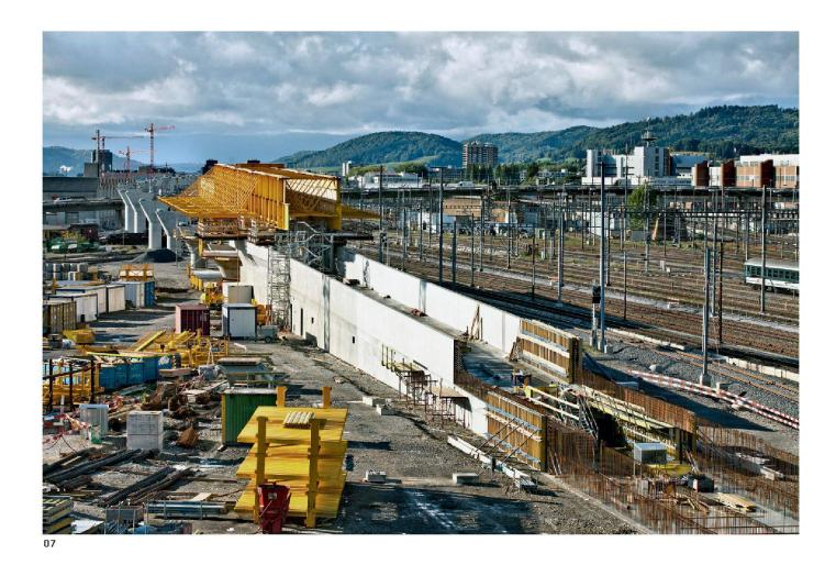
07 Die Auffahrtsrampen werden gleichzeitig mit den Pfeilern erstellt. Auf sie entfallen rund 800 m der insgesamt 2400 m Länge der Brückenkonstruktion. (Foto: SBB) 08 Die Letzigrabenbrücke überquert die Duttweiler-Strassenbrücke, die ihrerseits das Gleisfeld im Bereich Altstetten überquert. (Foto: alw)
