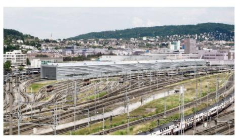
01 Die beiden neuen Hallen der SBB-Serviceanlage Herdern sollen ab Ende 2013 für den Unterhalt neuer, längerer Zugkompositionen bereitstehen. (Visualisierung: SBB)
