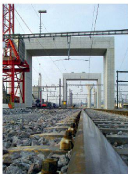
Die zwei neuen Brücken der Durchmesserlinie – im Bild die Portalrahmen und Pfeiler der Letzigrabenbrücke – ermöglichen eine kreuzungsfreie Führung des Fernverkehrs aus dem Bahnhof Löwenstrasse. (Foto: SBB)
