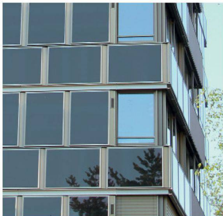
03 Saniertes Hochhaus der Siedlung Sihlweid in Zürich Leimbach. (Foto: Harder Haas Partner AG)
