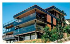
05 Norman-Foster-Solar-Award: Das siebenstöckige Mehrfamilienhaus Fent in Wil SG erreicht mit gut in Dach- und Fassadenflächen integrierten PV-Anlagen 186 % Eigenenergieversorgung.
