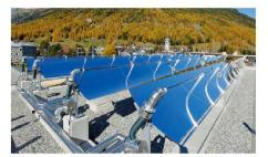
03 Kategorie Anlagen: Auf dem Dach der Lateria Engiadinaisa in Bever GR erzeugt eine 65-kW-Hochtemperatur-Solaranlage Dampf für die Milchverarbeitung und spart so 7000 1 Heizöl.
