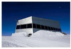
02 Die Fassade aus natureloxierten Aluminiumschindeln umhüllt den sechseckigen Kubus. Ein umlaufendes Fensterband ermöglicht einen 360°-Rundblick (Foto: Scherrer Metec)
