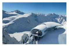
01 Der Bau steht auf Stützen, um die Erwärmung des Bodens durch die Betriebstemperatur des Gebäudes zu vermeiden (Visualisierung: Baumschlager Hutter Partners)
