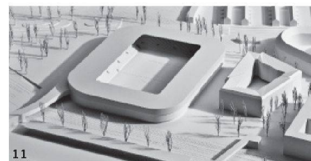
07–09 Ikonografische Erscheinung: «Beletage» von Graber Pulver Architekten. Das Fussballstadion ist als Ingenieurbauwerk erkennbar und besteht aus einem raumhaltigen gevouteten Fachwerk, das zusammen mit den Tribünenträgern eine Einheit bildet. Eine transluzente Hülle aus Metallgewebe gibt dem Bau eine wechselnde Tag- bzw. Nachtwirkung (Visualisierung und Pläne: Projektverfasser, Modellfotos: Iris Stutz)
