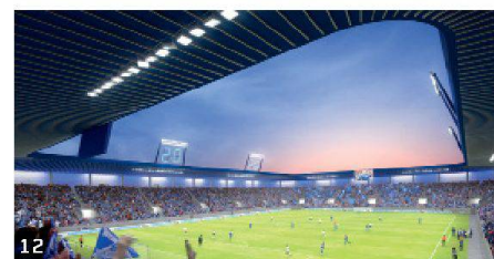
10–12 Unprätentiöse Robustheit: «Direkt verwandelt» von Gigon Guyer Architekten. Der Dachrand ist mit PV-Modulen bestückt, der eingezogene Sockel verkleinert die Grundfläche des Stadions. Dazwischen – vor dem «Stadtbalkon» genannten Umgang – spannt ein Metallgeflecht mit dem Stadionnamen
