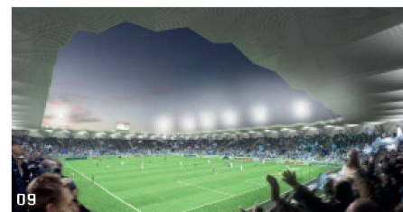
07–09 Ikonografische Erscheinung: «Beletage» von Graber Pulver Architekten. Das Fussballstadion ist als Ingenieurbauwerk erkennbar und besteht aus einem raumhaltigen gevouteten Fachwerk, das zusammen mit den Tribünenträgern eine Einheit bildet. Eine transluzente Hülle aus Metallgewebe gibt dem Bau eine wechselnde Tag- bzw. Nachtwirkung (Visualisierung und Pläne: Projektverfasser, Modellfotos: Iris Stutz)
