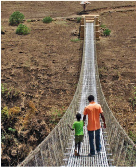
03 Am häufigsten werden Hängebrücken gebaut wie hier über einen Seitenfluss des Blauen Nils
