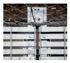
01 Stahlleisten und Armierungseisen des Gehwegs werden von äthiopischen Handwerkern zusammengeschweisst (Fotos: Danielle Fischer)
