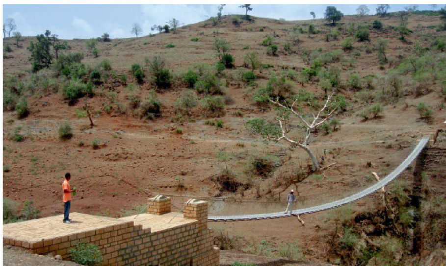
02 Die Dorfbevölkerung erstellt die Naturstein-Brückenpfeiler mit Fundament für die Verankerung. Mittels ihrer Höhe kann die Brücke den örtlichen Verhältnissen angepasst werden
