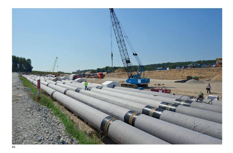
01 Übersteigt die Produktion aus Wind- und PV-Anlagen den Bedarf, kann der Strom zukünftig auch zur Herstellung von Wasserstoff oder Methan genutzt werden, das dann im vorhandenen Erdgasnetz gespeichert werden kann. Die Technologie ist jedoch noch im Entwicklungsstadium (vgl. Artikel S. 24). Im Bild ein Erdgas-Röhrenspeicher, den Erdgas Zürich derzeit in Urdorf ZH baut (Foto: Hannes Henz)
