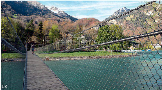
17–19 Aus in der dritten Runde: «Seilschaft» (Schnetzler Puskas Ingenieure): Der Gehweg der Hängebrücke ist mit einer Netzkonstruktion an den Hauptkabeln befestigt, an einem höher und straffer gespannten Kabel sind die systemkonformen Brüstungen befestigt. Der Bunker dient als Widerlager. Längsschnitt, Mst. 1:600; Querschnitt Stütze, Mst. 1:80
