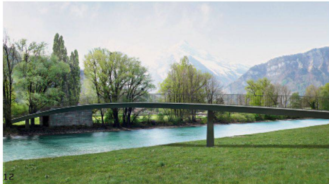
11–13 4. Preis: «Zenith» (Walt + Galmarini Bauingenieure, Zürich; LutzBuss Architekten, Zürich; Ganz Landschaftsarchitekten, Zürich). Äusserst schlanker dreifeldriger Durchlaufträger in Stahlbetonverbundbauweise. Längsschnitt, Mst. 1:600; Querschnitt im Scheitpunkt, Mst. 1:40 (alle Pläne + Visualisierungen: Projektverfasser)
