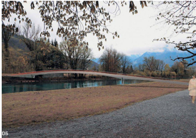
05–07 2. Preis: «Seeweg» (Dr. Schütz Beratende Ingenieure im Bauwesen, D-Kempten; Christoph Pahl, Architekt). Trapezförmiger Kastenträger mit variabler Höhe über zwei Felder. Die geneigten Stege werden 40 cm über den Gehweg geführt und bilden einen leichten Trog, zugleich generiert die Anordnung von drei Hohlkästen eine hohe Torsionssteifigkeit. Längsschnitt Mst. 1:600; Querschnitt in Brückenmitte, Mst. 1:60
