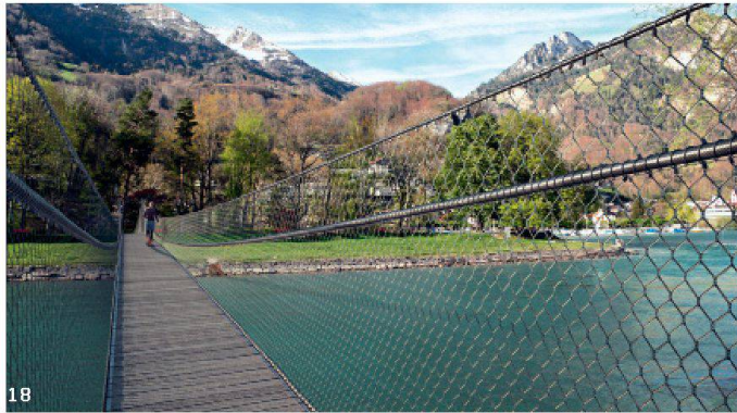
17–19 Aus in der dritten Runde: «Seilschaft» (Schnetzer Puskas Ingenieure): Der Gehweg der Hängebrücke ist mit einer Netzkonstruktion an den Hauptkabeln befestigt, an einem höher und straffer gespannten Kabel sind die systemkonformen Brüstungen befestigt. Der Bunker dient als Widerlager. Längsschnitt, Mst. 1:600; Querschnitt Stütze, Mst. 1:80
