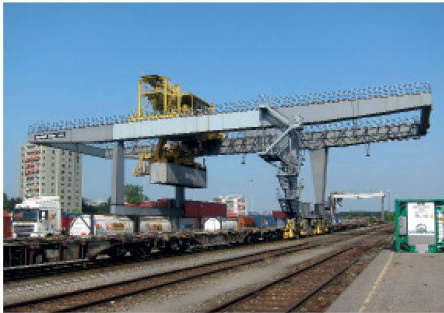
02 Basel Wolf ist heute ein wichtiges Umschlagterminal für den Import und Export. Künftig wird es für die Versorgung von Basel im kombinierten Verkehr benötigt (Foto: Vincent Baeriswyl)
