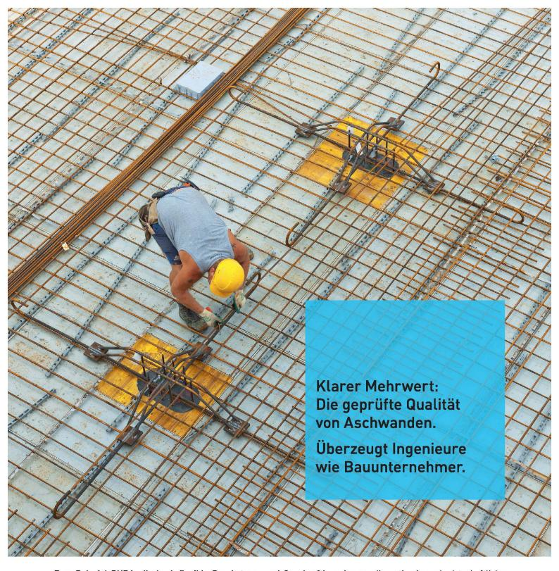
Zum Beispiel DURA, die hoch flexible Durchstanz- und Querkraftbewehrung, die optimale und wirtschaftliche Lösungen ermöglicht: Sicherheit und Qualität gewährleistet Aschwanden mit normenbasierten Systemen. Sie sind für die Bewehrung und Kraftübertragung im Stahlbetonbau unübertroffen. Unsere Produkte werden nach strengsten Standards von Spezialisten und Hochschulkapazitäten entwickelt und in diversen Grossversuchen an der EMPA oder der EPFL geprüft.
