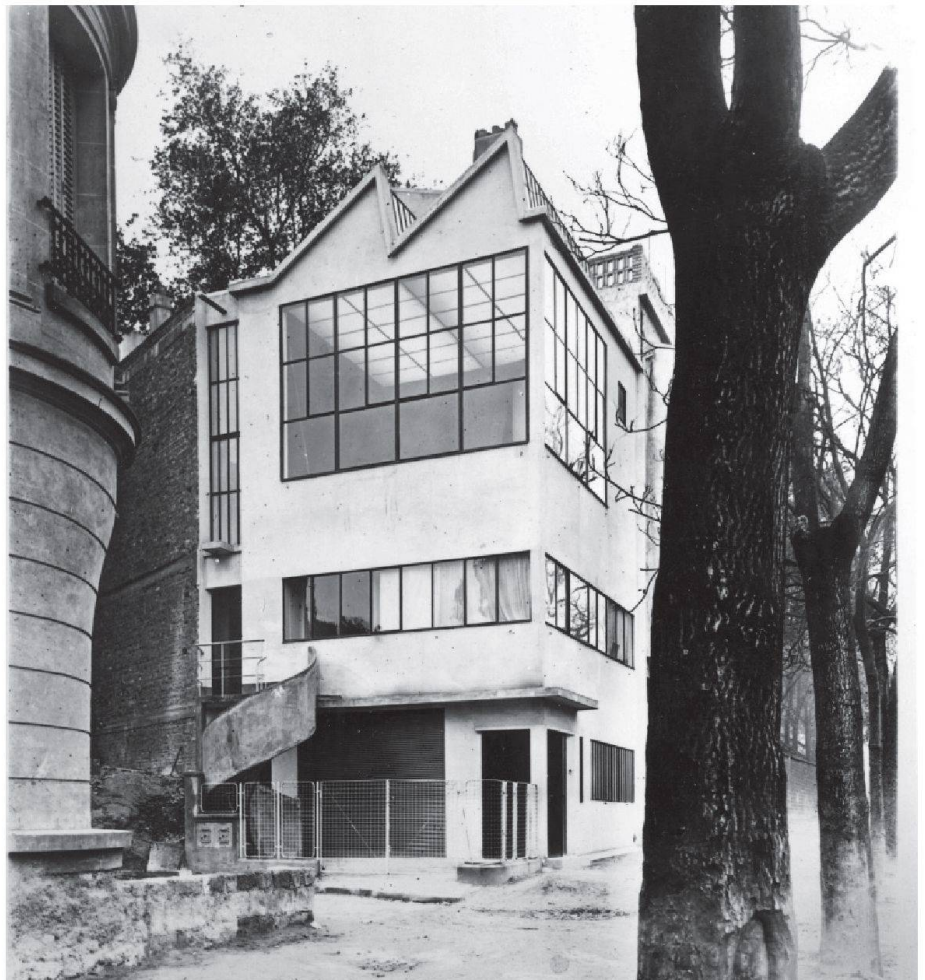
10 Atelier Ozenfant, Paris, 1923–1924. Aufnahme aus der Entstehungszeit. Ansicht der beiden Strassenfassaden, die nach Westen bzw. Norden orientiert sind. Die Fassaden des Ateliers erhielten einen Putz mit Portlandzement als Bindemittel, der zum Schutz mit Ölfarbe behandelt wurde. Das Sheddach des Ateliers wurde später durch ein Flachdach mit Balkon ersetzt
