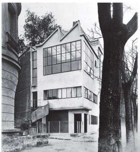
10 Atelier Ozenfant, Paris, 1923-1924. Aufnahme aus der Entstehungszeit. Ansicht der beiden Strassenfassaden, die nach Westen bzw. Norden orientiert sind. Die Fassaden des Ateliers erhielten einen Putz mit Portlandzement als Bindemittel, der zum Schutz mit Ölfarbe behandelt wurde. Das Sheddach des Ateliers wurde später durch ein Flachdach mit
