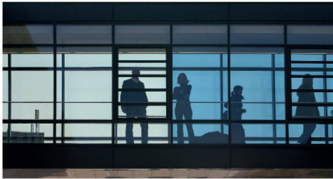
04 Diese Verbindungsbrücke des Fraunhofer-Instituts in Braunschweig wurde mit elektrochromen Gläsern ausgestattet, bei denen sich Licht- und Wärmedurchlässigkeit steuern lassen (Foto: EControl-Glas GmbH & Co. KG)
