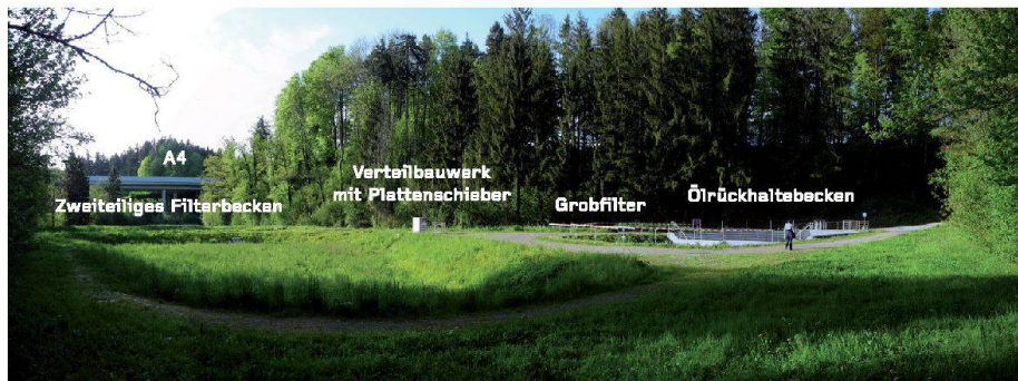
01 Panoramaansicht der Öko-SABA Wassermatt der A4 im Raum Hedigen/Zwillikon (bei km 46.6) mit grossem Einzugsgebiet (ca. 33 ha) und langer Transportleitung vom Tiefpunkt zur SABA, entwässert via Jonen in die Reuss (Projekt: ewp AG, Effretikon) (Foto: Peter Sulser)
