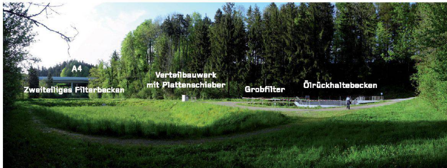
01 Panoramaansicht der Öko-SABA Wässermatt der A4 im Raum Hedigen/Zwillikon (bei km 46.6) mit grossem Einzugsgebiet (ca. 33 ha) und langer Transportleitung vom Tiefpunkt zur SABA, entwässert via Jonen in die Reuss (Projekt: ewp AG, Effretikon) (Foto: Peter Sulser)
