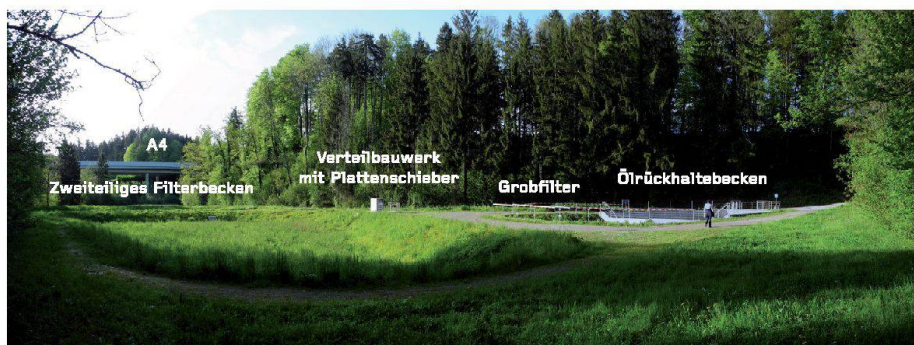
01 Panoramaansicht der Öko-SABA Wassermatt der A4 im Raum Hedigen/Zwillikon (bei km 46.6) mit grossem Einzugsgebiet (ca. 33 ha) und langer Transportleitung vom Tiefpunkt zur SABA, entwässert via Jonen in die Reuss (Projekt: ewp AG, Effretikon) (Foto: Peter Sulser)
