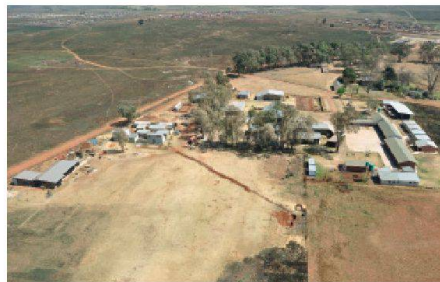
02 Luftbild des Campus. Neben Klassenräumen sind auf dem Gelände inzwischen auch Unterkünfte für Lehrende und Werkstätten entstanden
