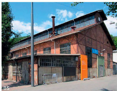
05 Die Schmiedehalle wurde 1906 erstellt und ist ein mit Backstein in Läuerschichten ausgefachter Stahlfachwerkbau unter einem Satteldach. Der offene Dachstuhl besteht aus Stahl und hat eine für die ursprüngliche Nutzung als Schmiede typische hohe Firstlaterne. In Baden sind alle anderen Hallen dieses Bautyps abgebrochen worden, die Schmiedehalle ist der letzte erhaltene Zeitzeuge. 2005 wurde das nahe Umfeld der Halle neu gestaltet (Schmiedepplatz-Gestaltung). 2011 wurde die Haupthalle der «Alten Schmiede» als industriegeschichtliches Zeugnis unter kantonalen Schutz gestellt (Foto: Jurybericht)
