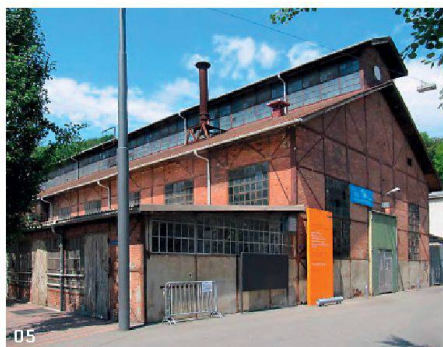
05 Die Schmiedehalle wurde 1906 erstellt und ist ein mit Backstein in Läuerschichten ausgefachter Stahlfachwerkbau unter einem Satteldach. Der offene Dachstuhl besteht aus Stahl und hat eine für die ursprüngliche Nutzung als Schmiede typische hohe Firstlaterne. In Baden sind alle anderen Hallen dieses Bautyps abgebrochen worden, die Schmiedehalle ist der letzte erhaltene Zeitzeuge. 2005 wurde das nahe Umfeld der Halle neu gestaltet (Schmiedeplatz-Gestaltung). 2011 wurde die Haupthalle der «Alten Schmiede» als industriegeschichtliches Zeugnis unter kantonalen Schutz gestellt (Foto: Jurybericht)
