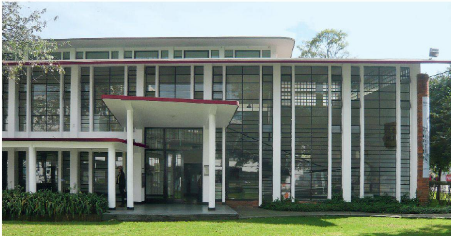
01 Eingangsbereich des Architekturmuseums in Bogotá. Die Bauten des Campus der Universität wurden in traditioneller Bauweise errichtet: Tragwerk aus Beton, Ziegelummauerung und Fenster mit Eisenrahmen (Fotos: Charles von Büren)
