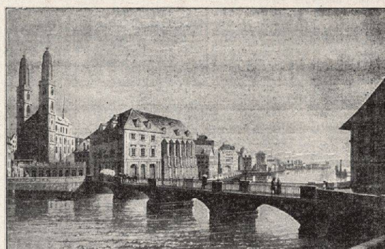
Münsterbrücke erbaut 1835—1838 Bogen zu 49 Fuss Spannweite
