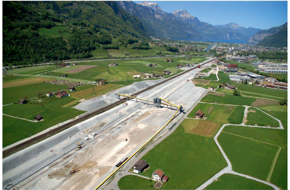
02 Der Zulauf zum Gotthardbasistunnel im Urnerboden. Nach der Inbetriebnahme steht die Schweiz vor grossen Herausforderungen im Bereich der Infrastruktur-, der Raum- und Verkehrsentwicklung (Foto: AlpTransit Gotthard AG)
