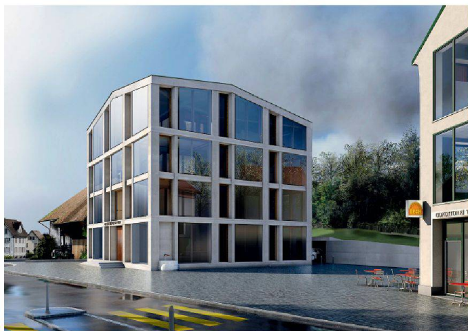
01+02 «Gio» (ARGE Imhof Nyffeler mit Joos & Mathys Architekten): Aussen Beton-, innen Holzskelettbau (Visualisierungen + Plan: Projektverfassende)
