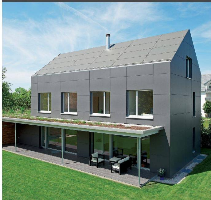
Dachgestaltung, die durch ihre zurückhaltende, flächige Wirkung überzeugt. INTEGRAL PLAN ist bereits ab einer Dachneigung von 6° möglich.
