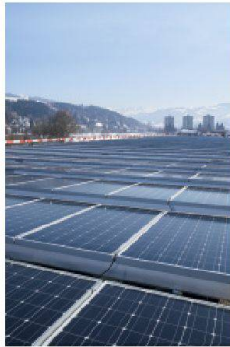
Fotovoltaikanlage auf dem Dach eines Fabrikgebäudes in Wattwil (SG). Mit einer Solarzellenfläche von 7163 m 2 ist es eine der grössten Anlagen in der Ostschweiz (Foto: Hannes Henz)
