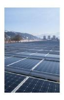
Fotovoltaikanlage auf dem Dach eines Fabrikgebäudes in Wattwil (SG). Mit einer Solarzellenfläche von 7163 m² ist es eine der grössten Anlagen in der Ostschweiz (Foto: Hannes Henz)
