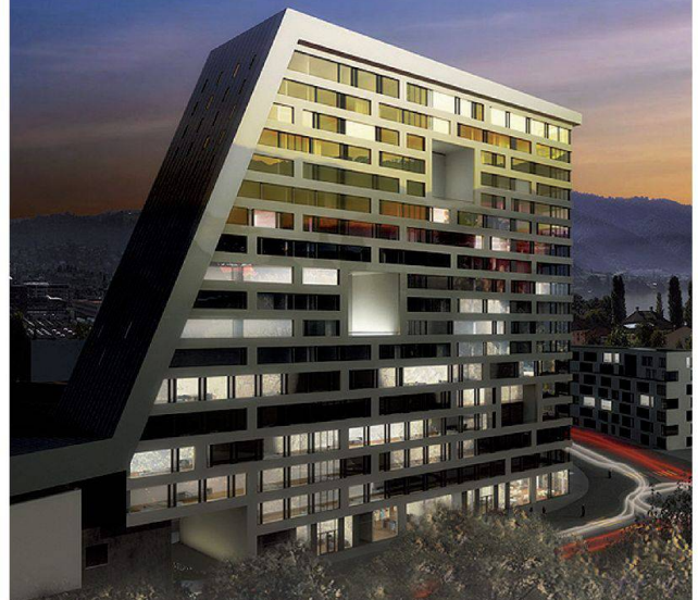
Hochhaus upfown in Zug Architektur: Scheitlin-Syfrig+Partner Architekten AG, Luzern
