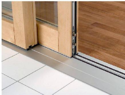
Das ebenerdige Schwellensystem der Alumat Rey GmbH, das auf einer DoppelmagNETTURDichtung basiert, kann bei Neu- und Umbauten für Aussentüren verwendet werden. Bei dem System ist die Ableitung von Regenwasser wichtig. Um zu verhindern, dass Feuchtigkeit in die Innenräume gelangt, wurde ein spezielles Ablaufsystem integriert. Eine verstellbare Silikon-Schleifdichtung im Wetterschenkel sorgt außerdem dafür, dass Schmutzablagerungen die Magnetfunktion nicht beeinträchtigen.
