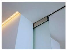
Das Schiebebeschlagsystem Hawa-Junior verfügt über eine rostfreie, leicht gleitende Achse. Auf ihr ist ein Beschlag mit zwei Kunststoffrollen und Gleitlagern aufgebaut. Die Hawa-Junior-Familie umfasst Beschläge für Holz-, Glas- und Metallschiebetüren von 40–250 kg Tragkraft. Für jede Anwendung und jedes Material stehen Aufhängungsvarianten zur Verfügung. Es gibt die Türen einflüglig, symmetrisch und teleskopisch platzsparend. Sie können unsichtbar an der Wand oder in der Decke montiert werden.
