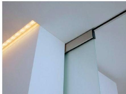
Das Schiebebeschlagsystem Hawa-Junior verfügt über eine rostfreie, leicht gleitende Achse. Auf ihr ist ein Beschlag mit zwei Kunststoffrollen und Gleitlagern aufgebaut. Die Hawa-Junior-Familie umfasst Beschläge für Holz-, Glas- und Metallschiebetüren von 40–250 kg Tragkraft. Für jede Anwendung und jedes Material stehen Aufhängungsvarianten zur Verfügung. Es gibt die Türen einflügelig, symmetrisch und teleskopisch platzsparend. Sie können unsichtbar an der Wand oder in der Decke montiert werden.
