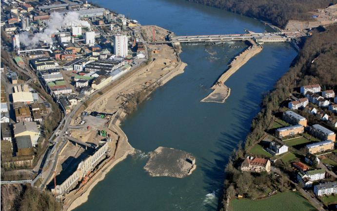
01 Flugaufnahme des alten Wasserkraftwerks in Rheinfelden aus Südwesten. Im Vordergrund links das Maschinenhaus, dahinter der Oberwasserkanal, im Hintergrund das Wehr. Links
