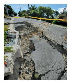
01 In der Sumner Road bei Christchurch ist das Phänomen der Bodenverflüssigung deutlich erkennbar: Sand und Silt verflüssigten sich unter den vom Erdbeben hervorgerufenen Bodenerschütterungen. Der Boden an leichter Hanglage fliesst talwärts und reisst die Strassendecke auf (Foto: KEYSTONE/MAXPPP/\*)
