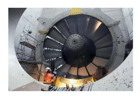
Leitapparat für eine der neuen Turbinen im Kraftwerk Rheinfelden (Foto: Energiedienst AG)
