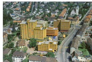
Zeitzeuge der frühen 70er in neuem Licht Stadt Zürich, Amt für Hochbauten Zürich
