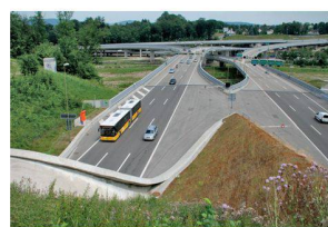
A4/A3 Westumfahrung Zürich Baudirektion Kanton Zürich – Tiefbauamt, Projektieren und Realisieren Zürich
