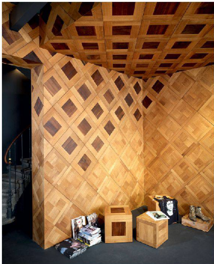
01 Eingangsbereich im Erdgeschoss: Das Parkett wurde vollflächig verklebt
