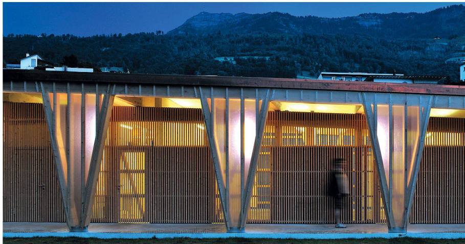
03 Noch stärker betont ist das Tragwerk beim Eindunkeln, wenn die zwischen die Holzlamellen gespannten Leuchten die V-Stützen durch die Polycarbonatplatten erhellen
