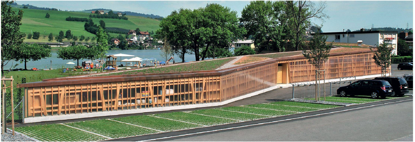
01 Landschaftliche Auffassung: Begrüntes Dach und Bepflanzung der Liegewiese mit Tulpenbaum, Blauglockenbaum, Katsurabaum und Erlen (Fotos: Sabrina Dohle)
