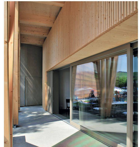
05 Die teilweise perforierten Polycarbonatplatten brechen das einfallende Licht
