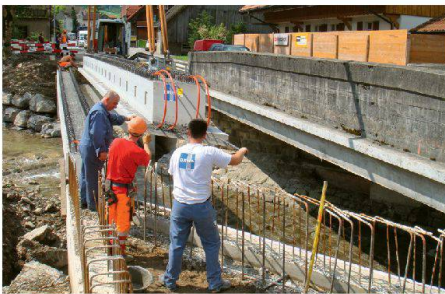
Montage erste Etappe mit bestehender Brücke daneben
