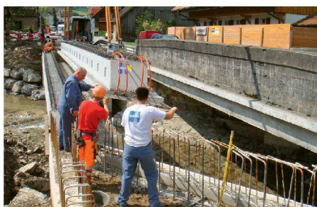
Montage erste Etappe mit bestehender Brücke daneben
