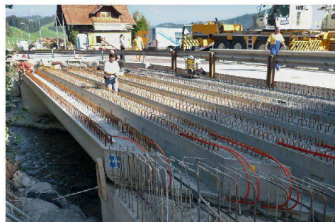
Montage zweite Etappe mit neuer Brücke der ersten Etappe für den Verkehr
