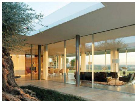
«SwissFineLine» ist ein Verglasungssystem für grossflächige Schiebefenster, das fliesende Grenzen zwischen innen und aussen erlaubt. Das Wärmedämmglas als selbsttragendes Strukturelement der Glasfront ermöglicht eine rahmenfreie Erscheinung und Schlichtheit. Die Fenster sind schwellenfrei mit im Boden versenkten Laufschienen und umlaufend in Wand und Decke unsichtbar eingelassenen Rahmen montiert. Sie werden in vollisolierter, thermisch getrennter Ausführung hergestellt.
