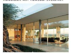
«SwissFineLine» ist ein Verglasungssystem für grossflächige Schiebefenster, das fliessende Grenzen zwischen innen und aussen erlaubt. Das Wärmedämmglas als selbsttragendes Strukturelement der Glasfront ermöglicht eine rahmenfreie Erscheinung und Schlichtheit. Die Fenster sind schwellenfrei mit im Boden versenkten Laufschienen und umlaufend in Wand und Decke unsichtbar eingelassenen Rahmen montiert. Sie werden in vollisolierter, thermisch getrennter Ausführung hergestellt.
