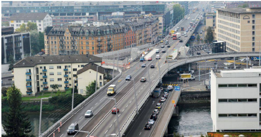
01 Bei der Instandsetzung der Hardbrücke in Zürich verzichtete man auf die Mittelbrüstung. Die Beleuchtung ist jetzt an den Rändern platziert (Foto: Andrea Helbling, arazebra)
