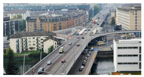
01 Bei der Instandsetzung der Hardbrücke in Zürich verzichtete man auf die Mittelbrüstung. Die Beleuchtung ist jetzt an den Rändern platziert (Foto: Andrea Helbling, arazebra)
