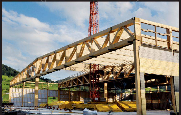
oben: Neubau Parkgarage und Skischule Innerarosa · Hauptträger aus BSH-Esche, Q = 220/1720 mm unten: Neubau Produktionszentrum, Fa. Strüby Holzbau AG, Leisibachstrasse 11, 6037 Root
