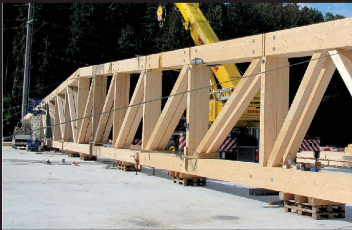
oben: Neubau Parkgarage und Skischule Innerarosa · Hauptträger aus BSH-Esche, Q = 220/1720 mm unten: Neubau Produktionszentrum, Fa. Strüby Holzbau AG, Leisibachstrasse 11, 6037 Root
