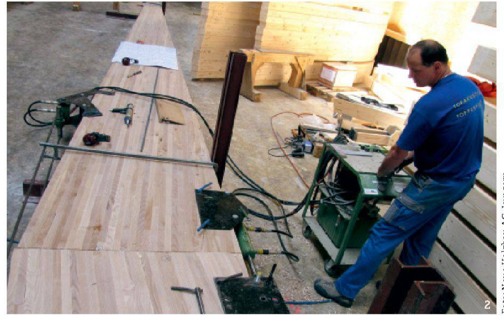
Foto: Neue Holzbau AG, Längern
