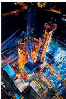
Die Erkundungsbohrung des Elektrizitätswerks der Stadt Zürich im Triemli-Quartier lieferte wichtige Informationen über den Untergrund, auch wenn keine wasserführende Gesteinsschicht gefunden wurde (Foto: ewz)
