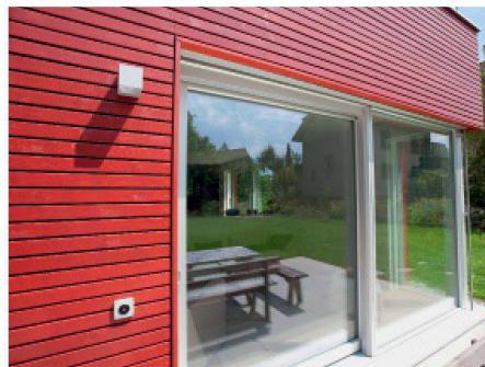
Bei der Hebeschiebetüre «Maxima» von Wenger wird der Wärmeverlust in den kritischen Zonen stark gesenkt, und die Oberflächentemperaturen werden erhöht. Beim unteren Festteil konnte der Uf-Wert des Rahmens von 2.0 W/m<sup>2</sup>K auf 0.95 W/m<sup>2</sup>K vermindert werden. Die Oberflächentemperaturen konnten bei der Rahmenpartie und der Mittelzone um 25% erhöht werden. Durch diese Verbesserungen liegen die Temperaturen bei einem Normalklima deutlich ausserhalb der Schimmelzone.
