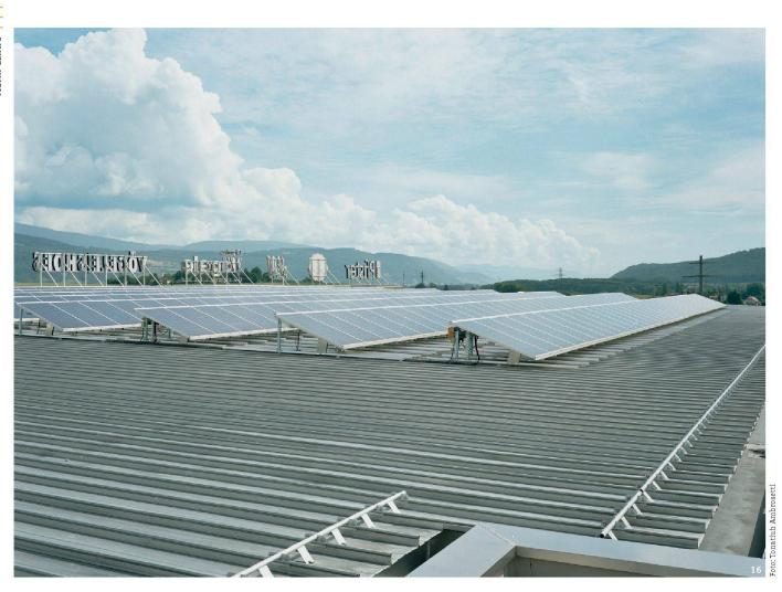
16 Auf dem Metalldach des Parkhauses ist eine Fotovoltaikanlage mit zurzeit 400 m² Fläche installiert
