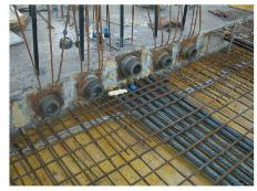
02 Ergänzende schlaffe Bewehrung aus höherfestem Betonstahl der teilweise vorgespannten Decke (Spannweite 50 m) beim Logistikzentrum Galliker in Aclens. Bauingenieur: Fent AG, Seon (Foto: Ingenieur)
