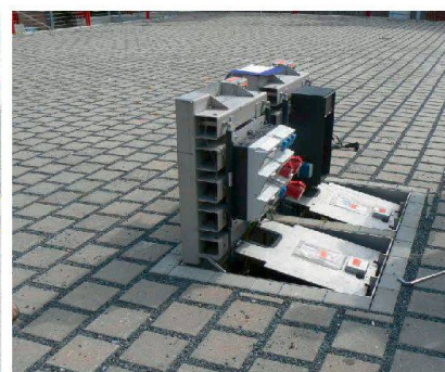
Unterflurelektranten
