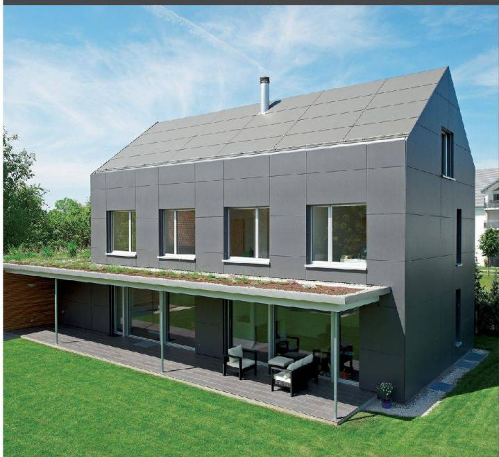
Dachgestaltung, die durch ihre zurückhaltende, flächige Wirkung überzeugt. INTEGRAL PLAN ist bereits ab einer Dachneigung von 6° möglich.
