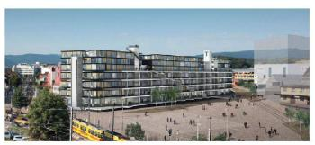
09 Petit Beaubourg: Das Team um Harry Gugger öffnet das Erdgeschoss mit einer öffentlichen Rampe zum Platz – die markante Kaskadentreppe an der Nordfassade inszeniert die Gebäudeerschliessung. Die serielle Aufstockung um drei Geschosse in Stahl-Leichtbauweise spielt mit dem Charakter des Industriegebiets
