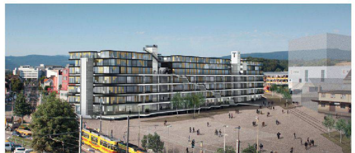
09 Petit Beaubourg: Das Team um Harry Gugger öffnet das Erdgeschoss mit einer öffentlichen Rampe zum Platz – die markante Kaskadentreppe an der Nordfassade inszeniert die Gebäudeerschliessung. Die serielle Aufstockung um drei Geschosse in Stahl-Leichtbauweise spielt mit dem Charakter des Industriegebiets
