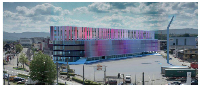
13 Öffentlicher Stadtbalkon: UNDEND Architektur setzen die neuen Wohnetagen zurück, die sich mit Loggien und Balkonen nach Süden öffnen. Vom Platzniveau führt eine grosszügige Freitreppe hinauf ins 3. Obergeschoss auf einen grossen öffentlichen Balkon, der Richtung Hochschule orientiert ist. Die grossflächige textile Fassade unterstützt diesen Bezug
