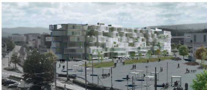
12 Skulpturales Containerlager: MVRDV nutzen das Lagerhaus als Regal für leichte Wohn- und Bürocontainer. Das Bild erzeugt einen hohen Wiedererkennungswert und vielfältige Aussen- und Zwischenräume. Allerdings führt das Konzept auch zu einer aufwendigen Verdreifachung der Konstruktion und erschwert das Einhalten des Minergie-P-Standards
