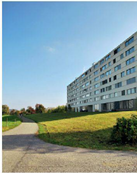
Die Siedlung «Aspholz» (pool Architekten) ist zurzeit die markanteste Klippe an Zürichs Nordküste in Affoltern (Foto: Anna-Lena Walther/Red.)
